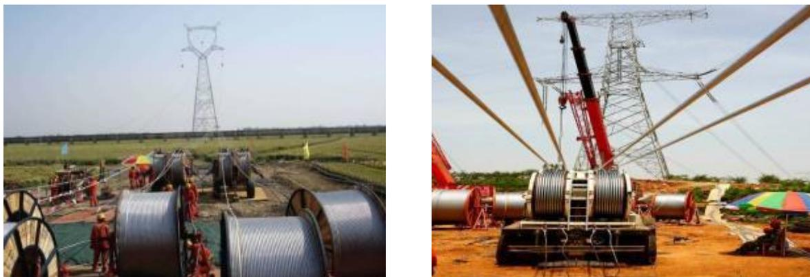
图 3.1-4 线路工程沿线牵张场布置形式照片
